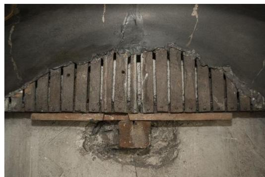
Figure 5:(En haut) Détail de la structure en bois derrière le tableau de l'Autel de l'Adoration. On voit bien une poutre en bois insérée dans le mur et qui soutient la structure en bois (renforcée par des ajouts récents horizontaux) ; les lattes (par endroits, planches de récupération) forment un grillage vertical qui fait de support au stuc. Cette partie n'est pas complètement décorée puisqu'elle est couverte par le tableau principal.
